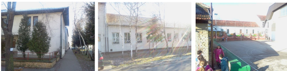
Слика 2: Комплекс предшколске установе и школе (део који прелази регулациону линију и спортски терени у дворишту)
