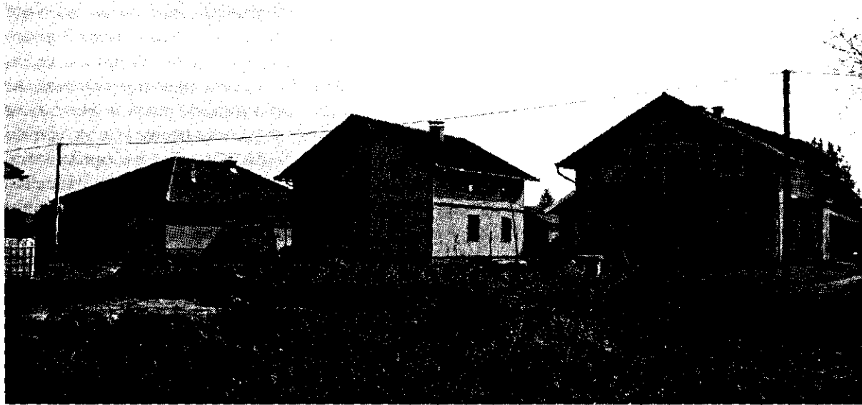
Бесправно изграђени објекти у унутрашњости блока 100
