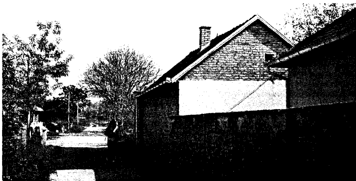
Објекат који је предвиђен за рушење, унутар планиране регулације Улице нова 2 у блоку 100
